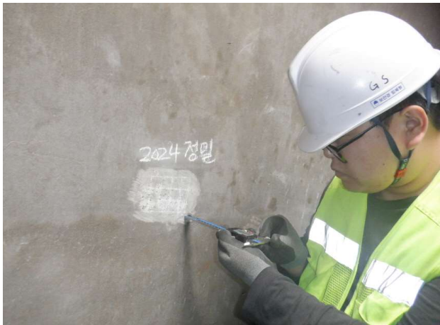
탄산화 깊이 측정
